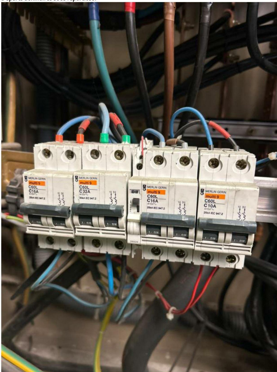
Départs auxiliaires sous répartiteur
